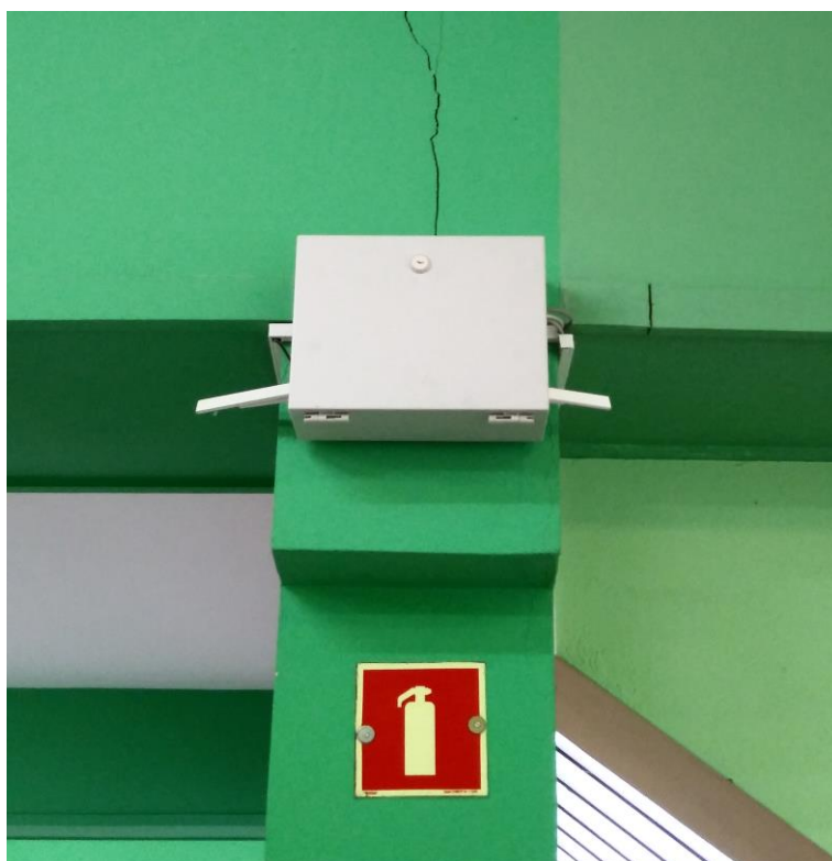
Fot. 5: Zdjęcie punktu dostępowego ukrytego w obudowie
